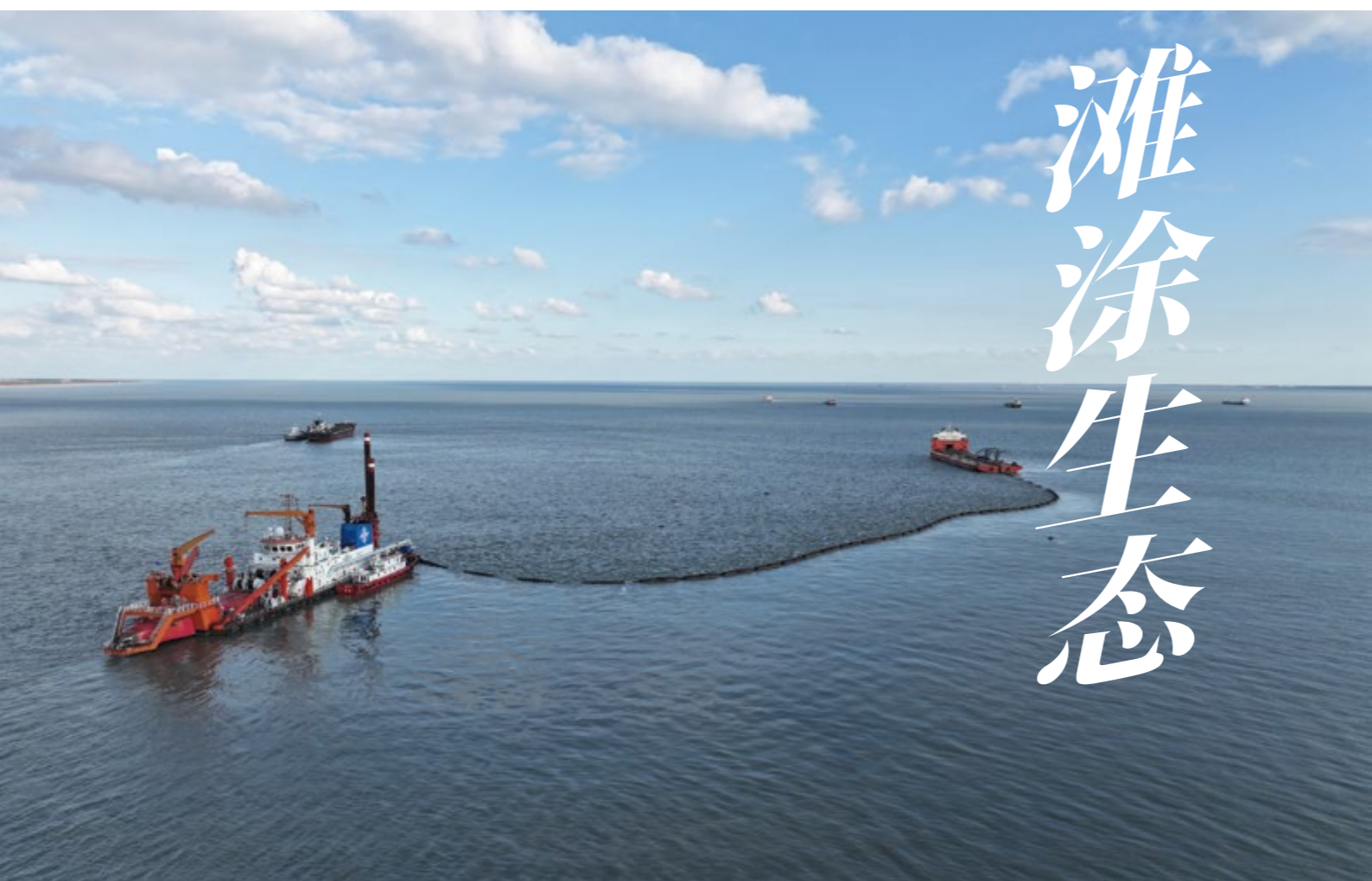
▲ “新海燕”绞吸船作业现场
